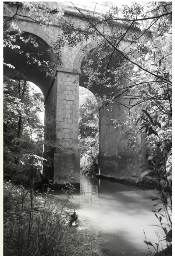
Le pont du canal de Saint Martory qui enjambe la Noue.
